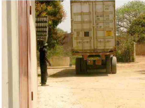
Wir weisen den ersten Lastwagen dicht an die Hauswand ein
