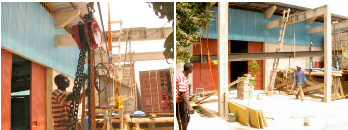
Mit Kettenzügen und Spannssets ziehen wir den Träger Stück für Stück höher
