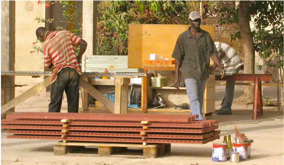
Omar links und Ousmane (mit Hut) reinigen und streichen Stützen der Einbaugestelle
