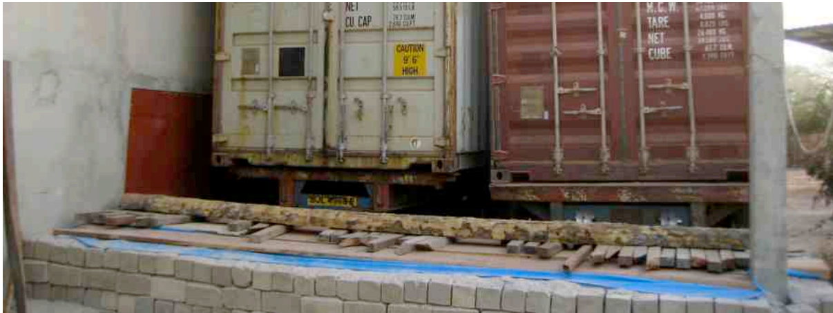
Das vorbereitete Auflager dient nun nicht wie geplant zum Auflegen der Container, sondern als Unterkonstruktion der Bühne
