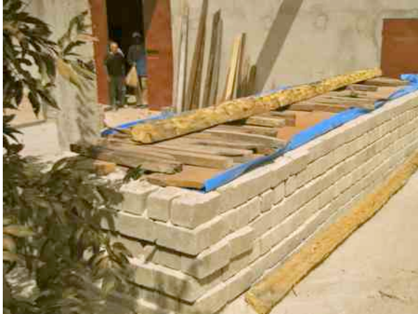
Das hintere Auflager ist bereit, die Container darauf abziehen
